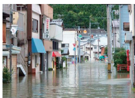
平成26年8月の台風第11号による浸水被害（高知県四万十町）
