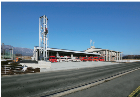
平成27年4月より運用を開始した 上伊那広域消防本部・伊那消防署庁舎
